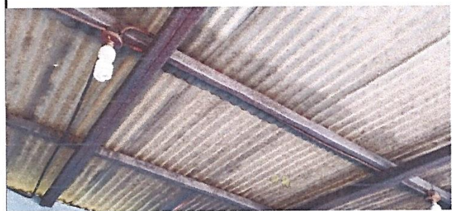
Foto 6: Cambio de techo de cocina
