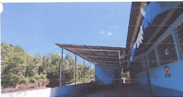
Foto 5: Culminación de entechado pasio
