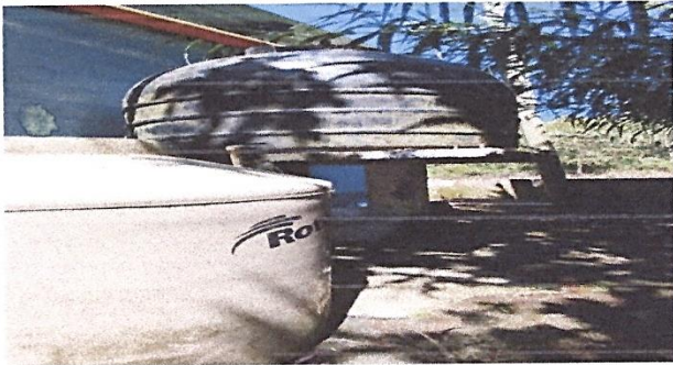
Foto 3: Tanque de Cisterna y sustitución de bomba
