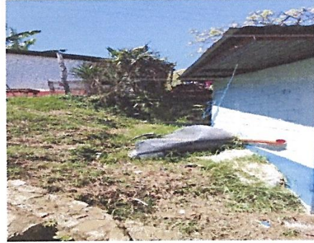
Foto 2: Entechado y realización de pila.
